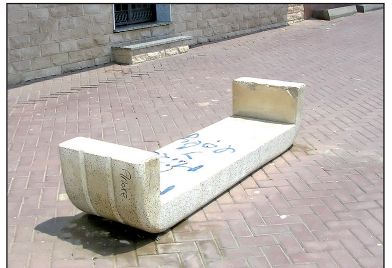
Mobiliario urbano deteriorado/P.A.
